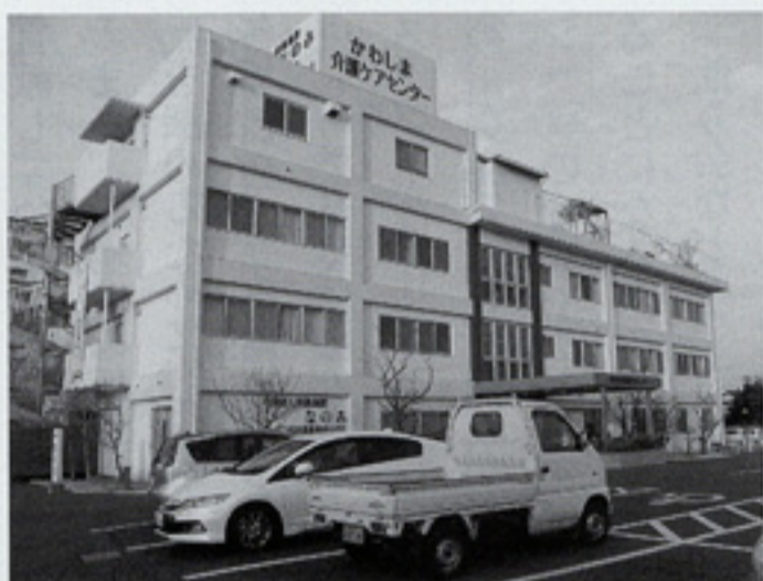
老健、サ高住、介護サービスを併設した介護ケアセンター
