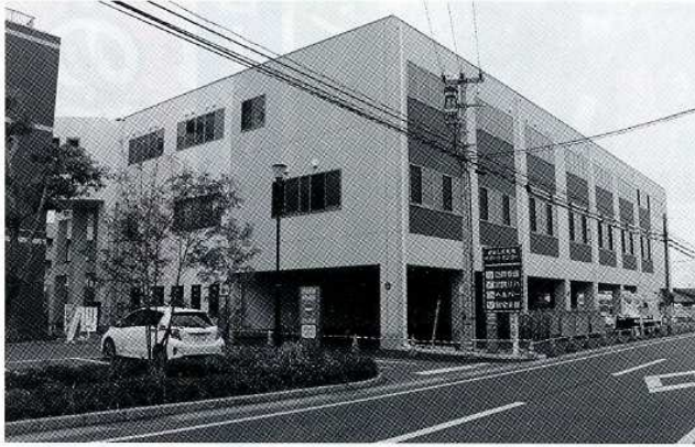
4月1日から開院した川島整形外科病院の西側に開院した回復期リハビリテーション病棟
