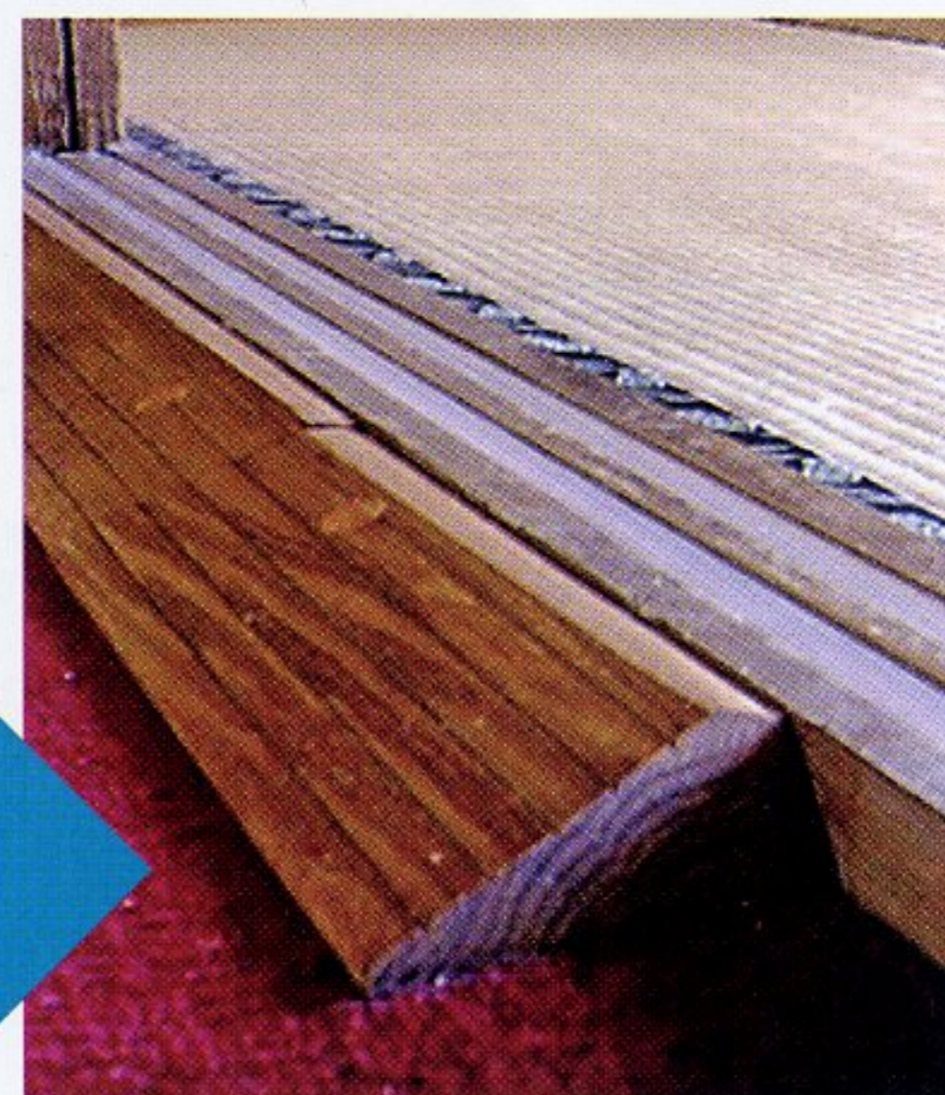
敷居の段差に傾斜板を設置
